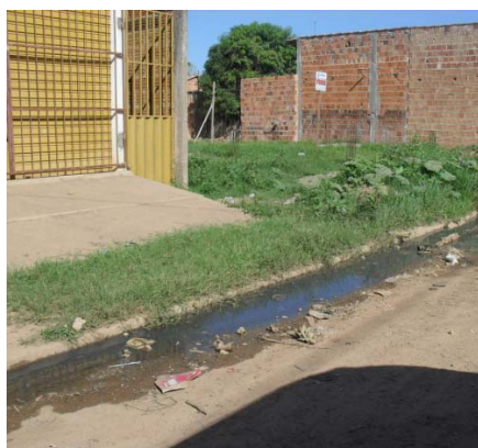
Fig. 6. Precariedade do Saneamento Básico no bairro Liberdade
